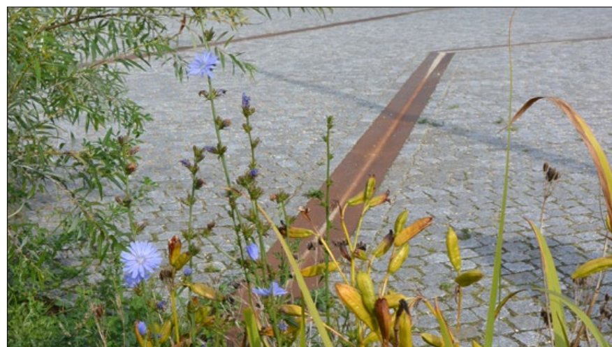
Vand ledes fra vandtrappe til bassin i en nedfræset rende.
