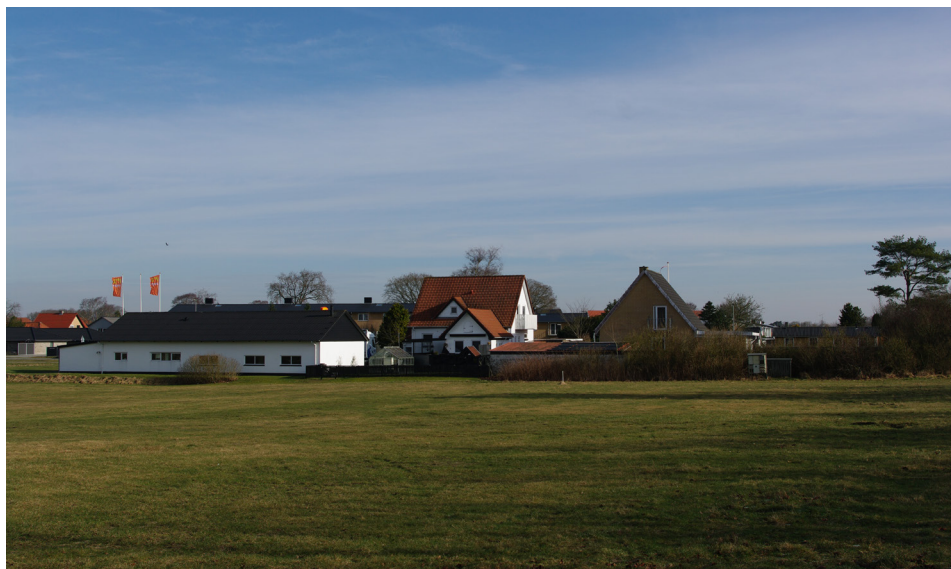
Eksisterende bebyggelse mod Over Jerstalvej.
