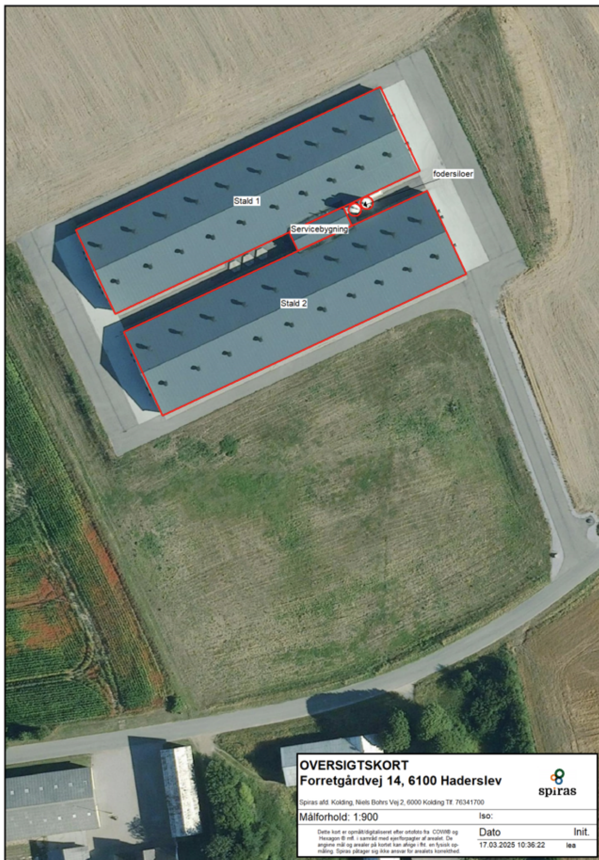
Figur 1 Stalde på Forretgårdvej 14
