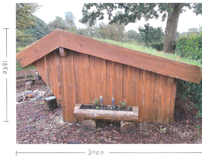
Figur 16 Foto fra ansøgning af shelter set fra siden og med angivelse af mål.
