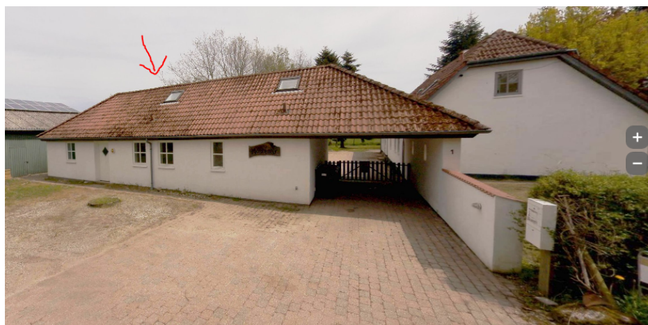
Streetview fra 2022 – Pilen viser bygning 2 - Der er ingen udvendige ændringer udover et ekstra vindue i facaden mod øst i forbindelse med ansøgning om kontorbrug i bygningen (ikke synligt her).
