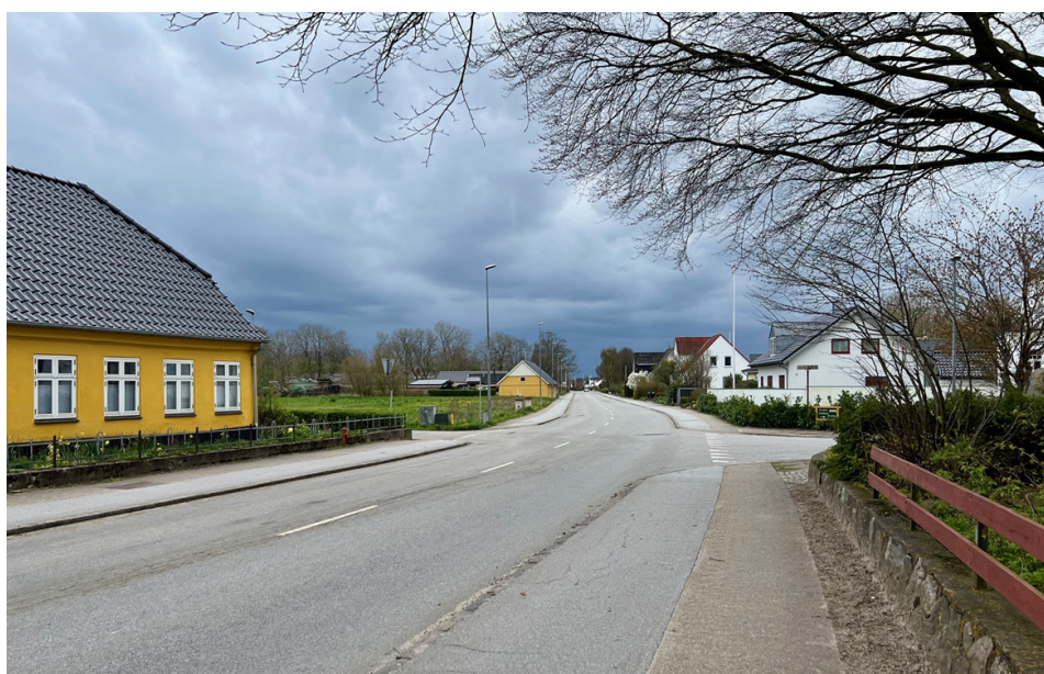
Lokalplanområdet set fra Storegade mod vest
