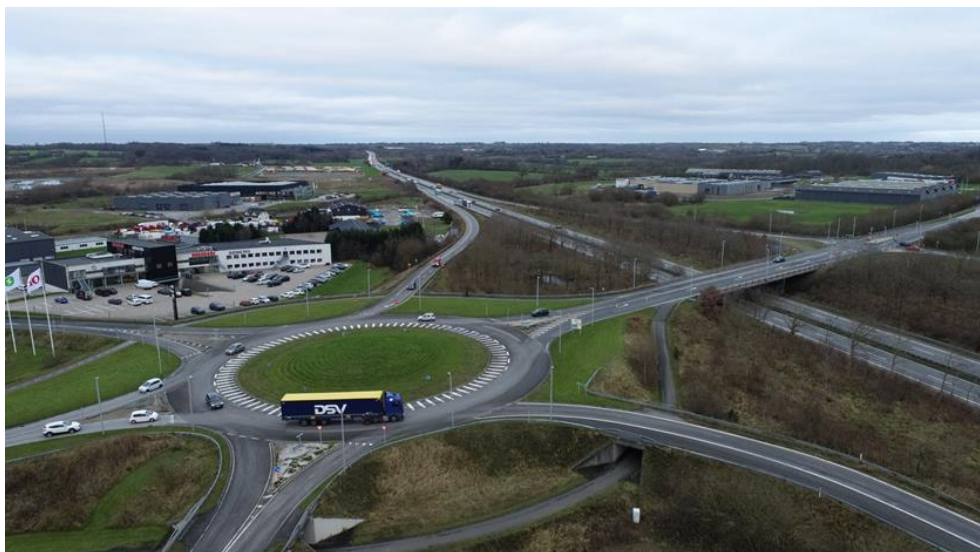
Figur 5-1 View fra droneoptagelsen ved TSA 68.
