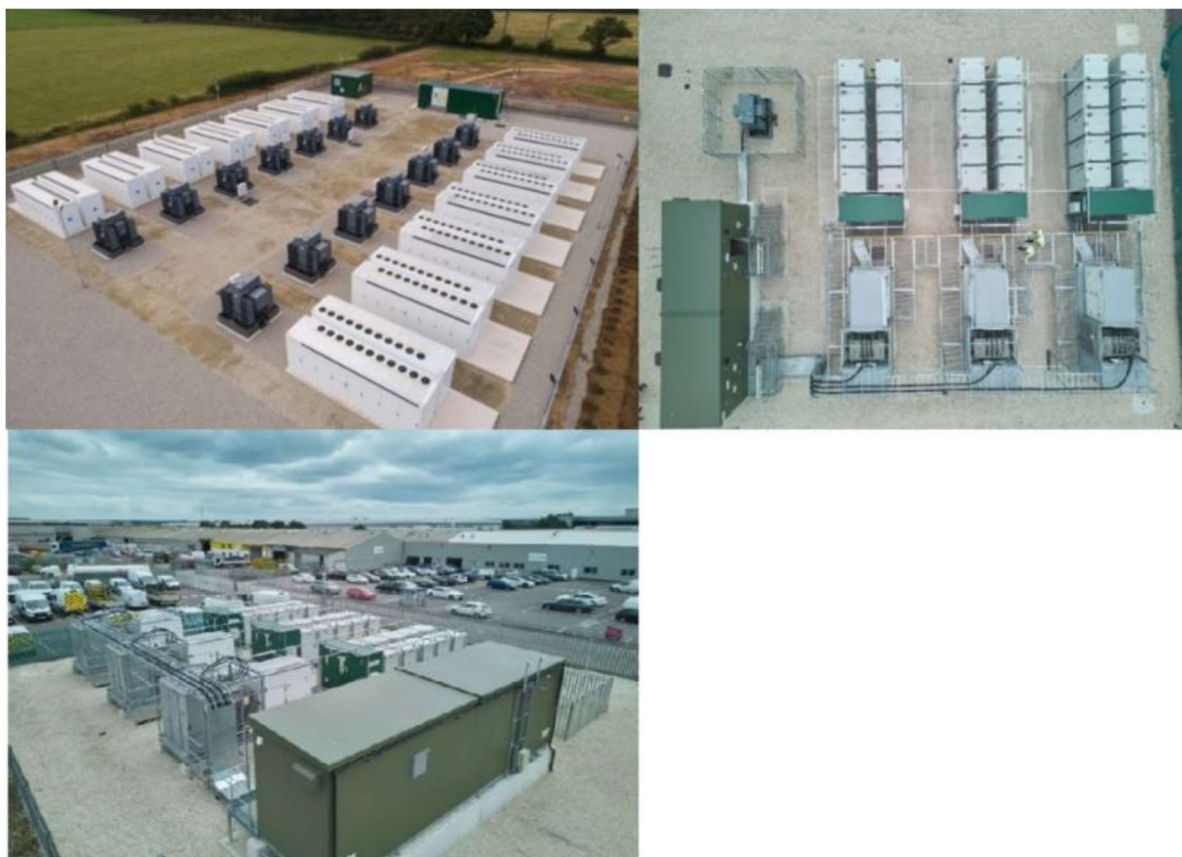
Figur 1 Type anlæg BESS
