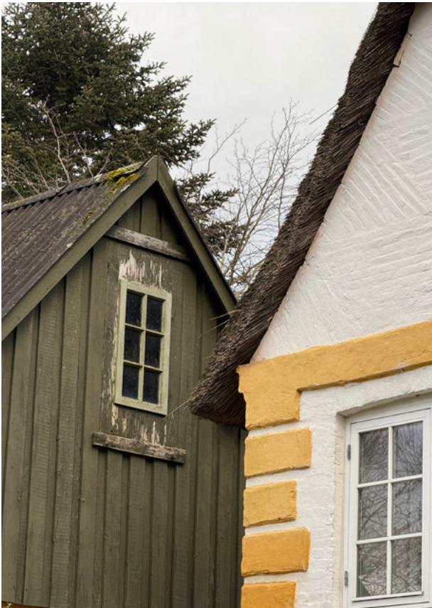
Eksisterende foto Eksisterende hovedhus og nyere gavnlade ifm. tag- ombygning (fra stråtag til bølgeeternit) post 1989.
