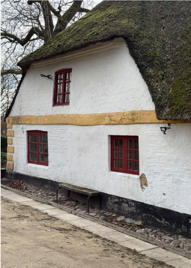
Eksisterende foto Sammenbygning (byg. 1 og 3). Fremstår afstumpet og med manglende detalje i murværk. Den manglende detal- je omkring murværket vil blive genetableret i det fremti- dige byggeprojekt.
