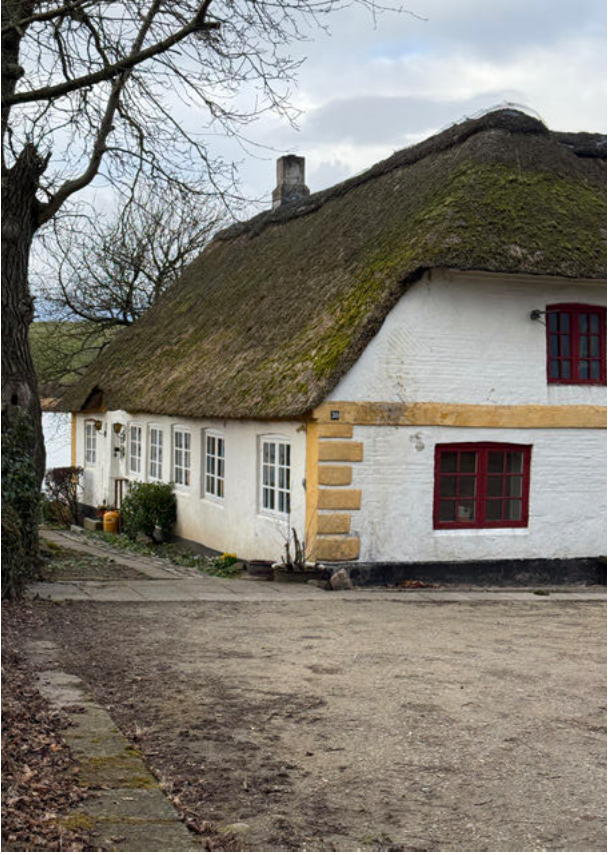
Eksisterende foto Ankomst, hovedhus. Der er monteret nye hvide vinduer (alu/plastik) i facade mod nord og vest. De røde (mere originale) vinduer er monteret mod syd og øst ind mod gården.
