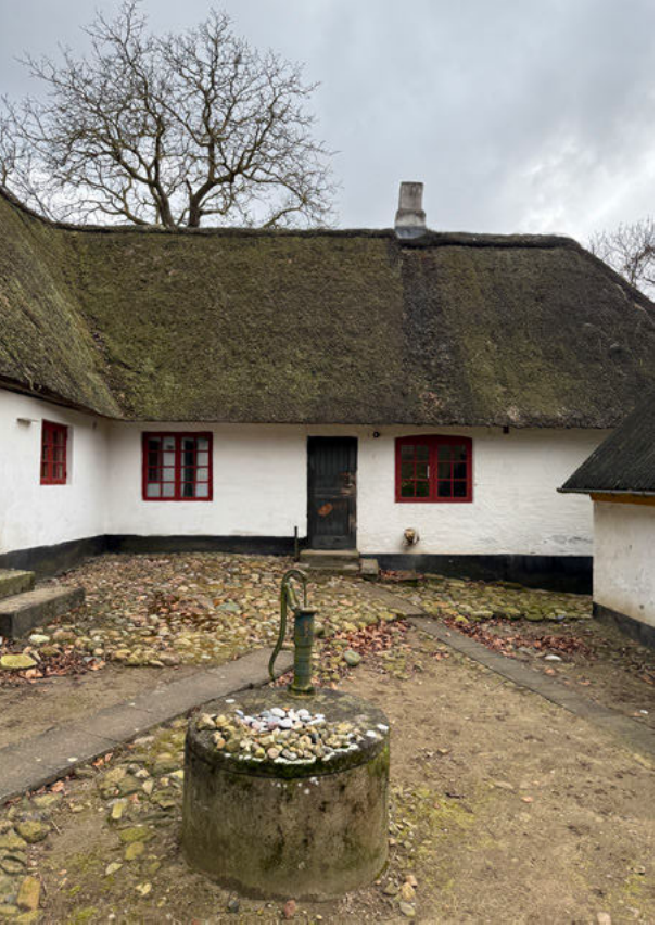
Eksisterende foto Eksisterende tilbygning (3) er sammenbygget med hovedhuset. Hovedhusets ydrevægge er registreret indvendigt i overgangen mellem de to bygninger. (dette kan ses i punktskymodel).
