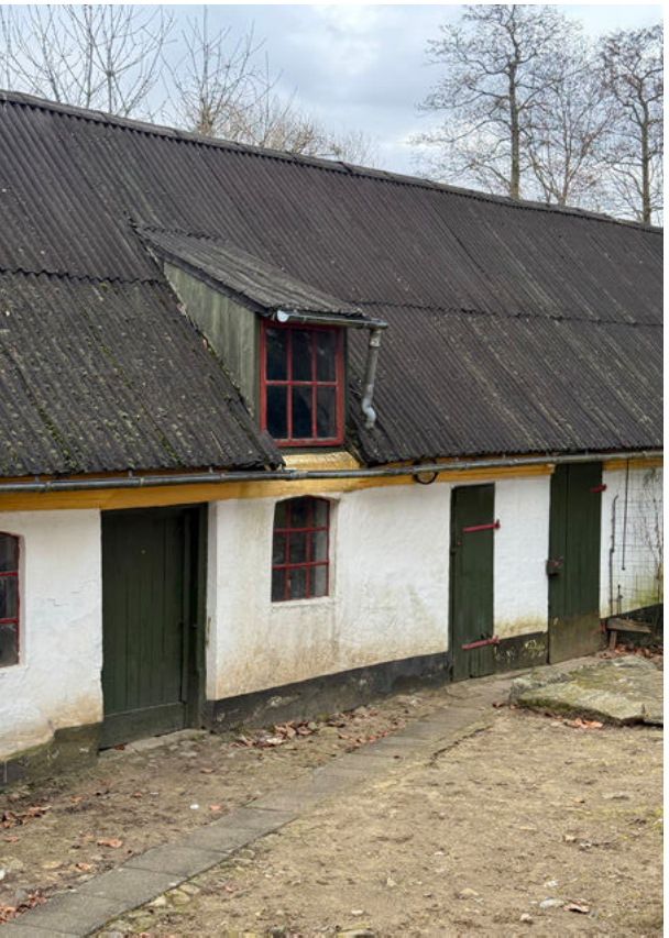
Eksisterende foto Bygning 2 med bølgeeternit (asbest) fremstår uoriginalt og ikke iht. vurd. af bevaringsværdi dateret 1989. Derudover er der registreret en udvidelse af laden (ikke dateret). Det vurderes derfor at laden fremstår meget uoriginal.
