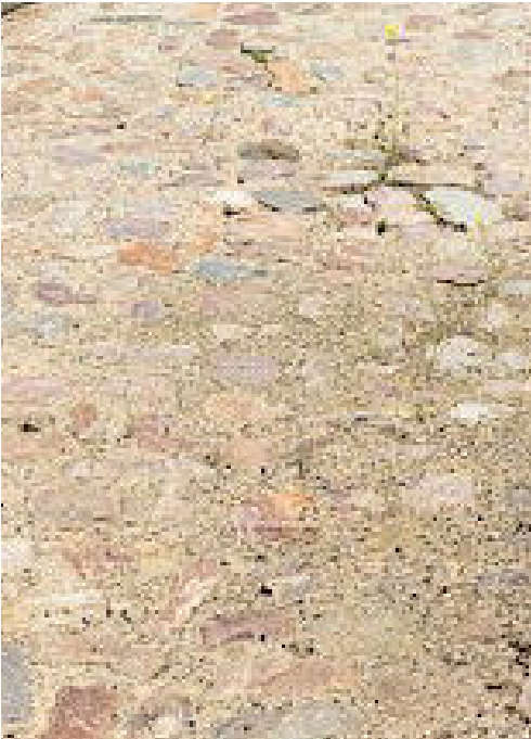
Gårdrum / I gårdrummet, der opstår mellem den eksisterende og nye bebyggelse, anlægges husets terrasse/gårdrum med pigsten og slotsgus.
