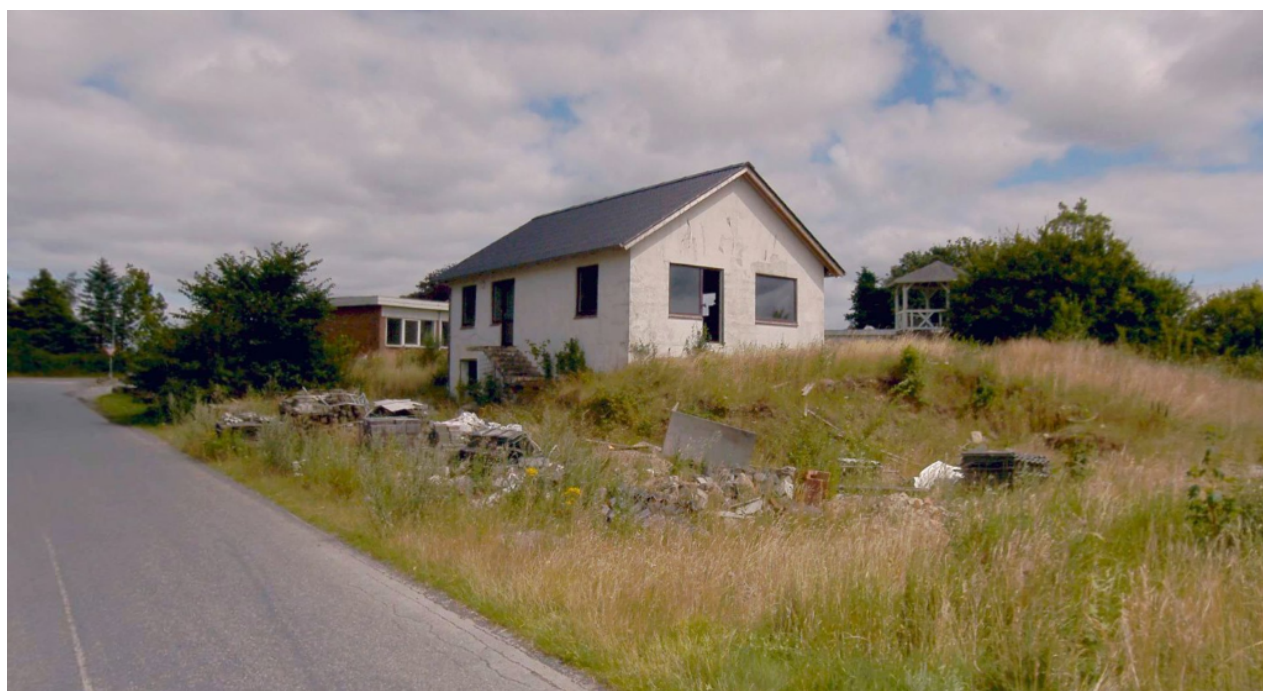
Foto af ejendommen fra Langdyssevej – den røde bygning i baggrunden er en del af naboejendommen Sluk Efter kro
