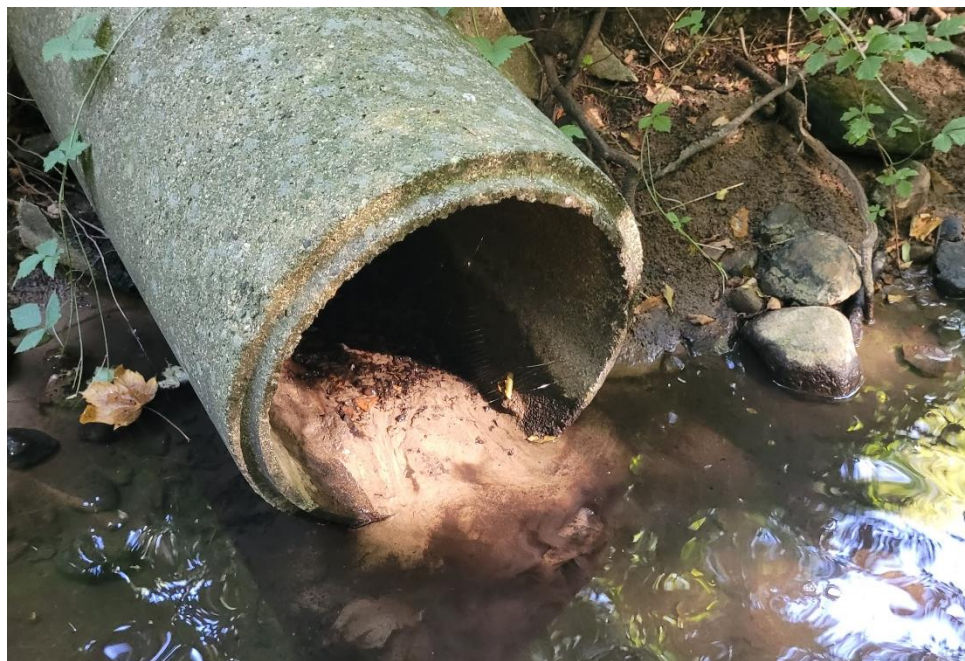
Figur 7: Eksempel på rørtilløb med sandtilførsel til vandområdet.
