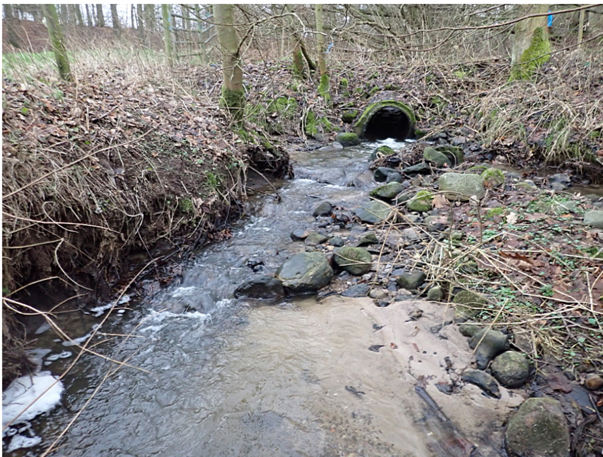
Figur 4. Strækning hvor der foreslås udlagt gydegrus til gydning og forbedring af passage gennem rørbro.
