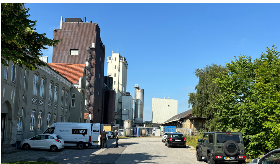
Fig. 4 Jernbanegade med kig mod Sophus Fuglsang Export-Maltfabrik
