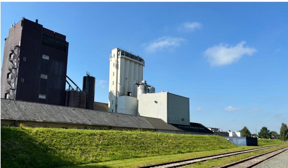
Fig. 11 Fabriksanlæg set fra nordsiden af baneterrænet ved Simmerstedvej
