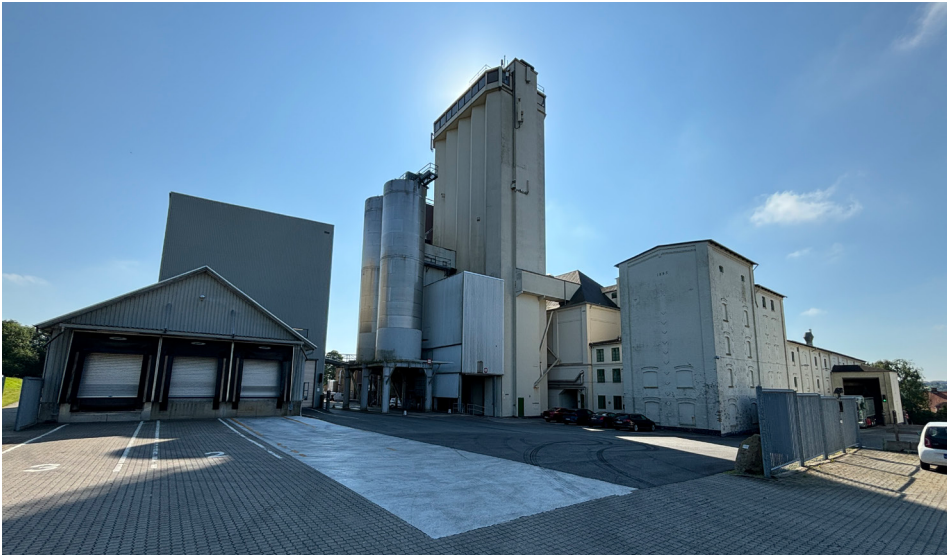
Fig. 6 Sække- og container læsseanlæg til venstre, øvrig fabriksanlæg til højre
